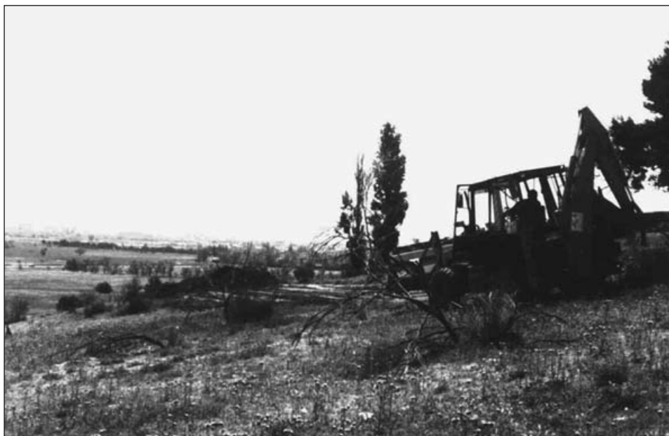
FIGURA 6.—Excavación de zanjas en el área del des poblado.
