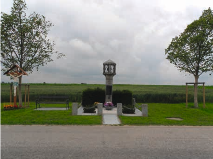
Abb. 4: Die Gedenkstätte Stillfüssing nach der Sanierung im Jahr 2015. Zentral an der Granitsäule ist die Gedenktafel angebracht, gut erkennbar ist auch links im Bild das Kruzifix.
