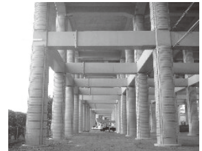
高架橋柱の耐震補強
