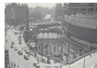
躯体工事中の北数寄屋ビル (1957/昭和 32 年)
