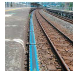
転落支障報知装置（マットスイッチ）
