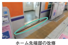
ホーム先端部の改修
