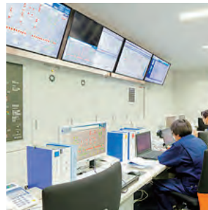
東京スカイツリータウン®を一元管理する 防災センター（東武ビルマネジメント）
