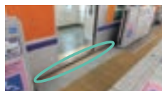
ホーム先端部の改修
