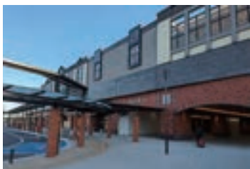
東武アーバンパークライン野田市駅 新駅舎外観
