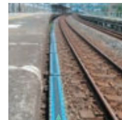
転落支障報知装置（マットスイッチ）
