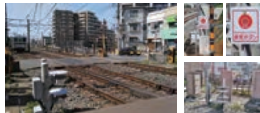
押ボタン式踏切支障報知装置
