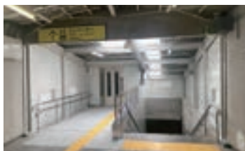
エレベーター
