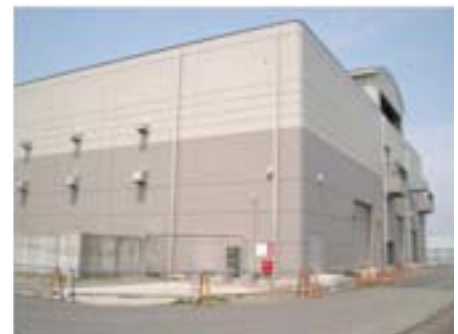
長町第一ポンプ場（仙台市下水道）
