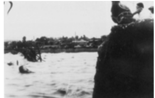
評定河原橋の流出
