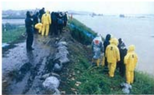
S61.8洪水 藤塚地区法崩れの状況
