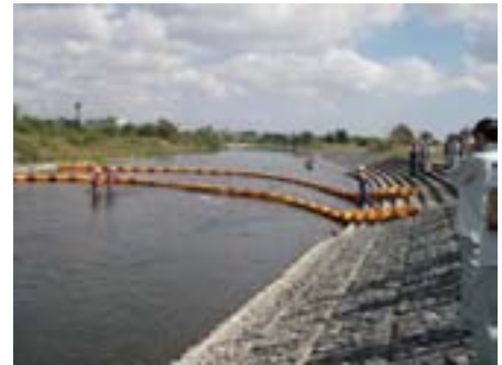
オイルフェンス設置訓練実施状況
