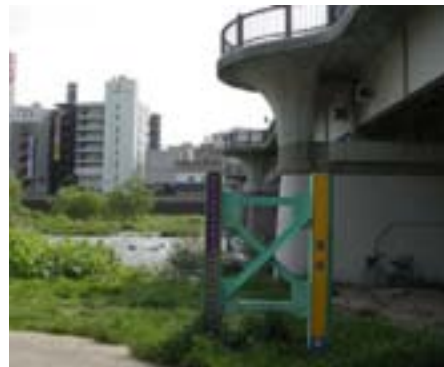
危険水位表示板（広瀬橋）
