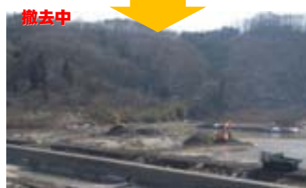
土砂撤去の状況(貯砂ダム) 出典：釜房ダム管理所資料
