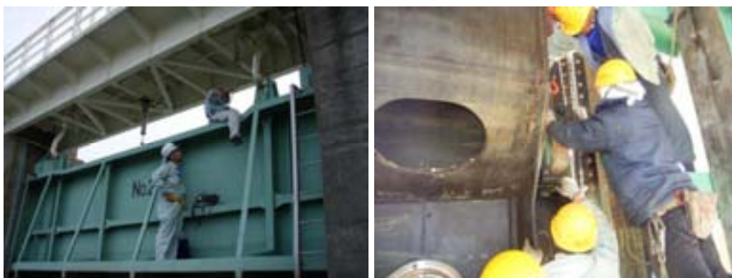
樋門・水門点検状況
