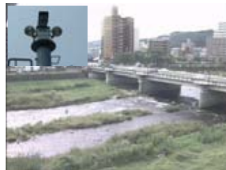
河川情報カメラの画像（広瀬橋）
