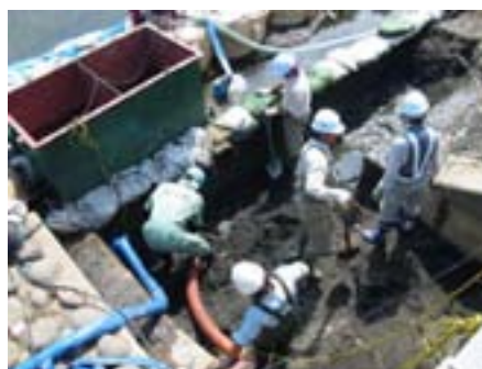
取水ポンプ場土砂撤去作業
