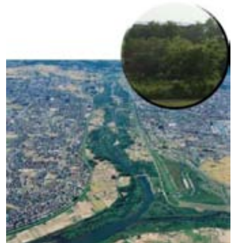
河道内樹木の状況
