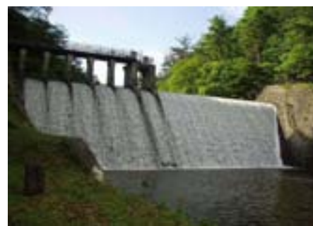
青下第二ダム
