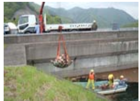
釜房ダム 流木処理
