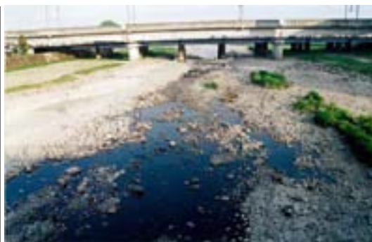
平成6年渇水時写真(広瀬川)
