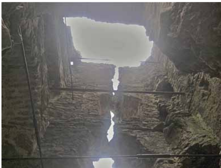
Foto 3. Tõmb-ankrud läänetornis. Alumised, mustaks värvitud tõmb-ankrud on paigaldatud 2008. aastal, ülemised rooste- sed 1930. aastatel (Foto: Uno Trumm, 2012).
