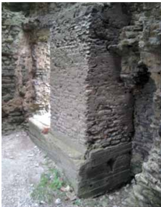
Foto 4, 5. Lõunatorni ukseava on konserveeritud tsementmördiga ilmselt 1934. aastal (Fotod: Uno Trumm, 2012).
