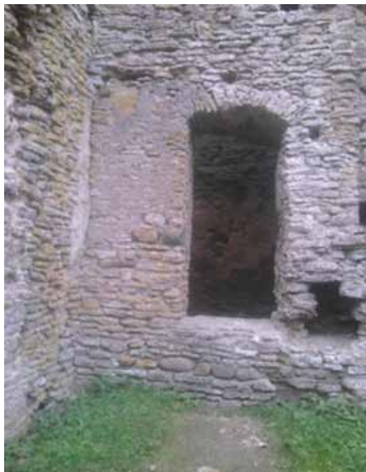
Foto 4, 5. Lõunatorni ukseava on konserveeritud tsementmördiga ilmselt 1934. aastal (Fotod: Uno Trumm, 2012).
