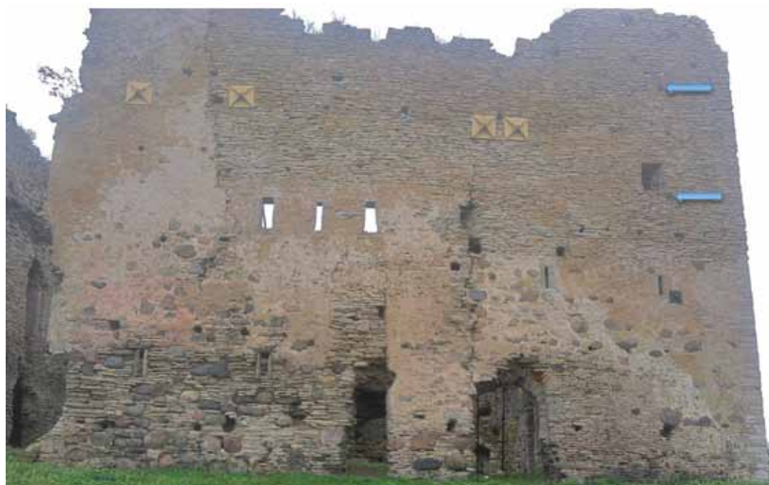
Foto 9. Tõmb-ankrute kinnitused lääneseinas: neli kollast ruudukujulist kinnist kuuluvad lääneseina tõmb-ankrutele, must 2008. aastal läänetorni paigaldatud tõmb-ankrule, 1930. aastatel paigaldatud ümara kinnisega tõmb-ankrutele osutavad nooled (Foto: Uno Trumm, 2012).
