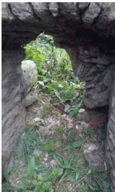
Foto 39, 40. Esimese eeshoovi läänemüüris olnud laskeava enne ja pärast konserveerimist, vaade sisehoovi (1) poolt (Fotod: Uno Trumm, 2014).
