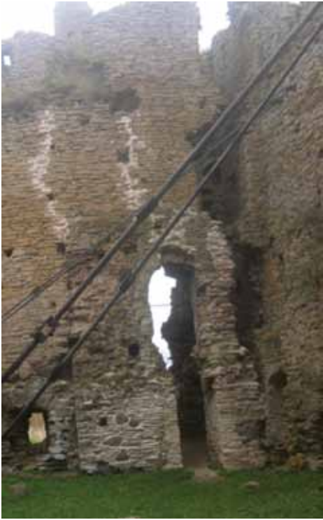
Foto 26, 27. Vaade läänetorni lõunaseinale. Juurdeladu müüri alaosas (Fotod: Uno Trumm, 2012).
