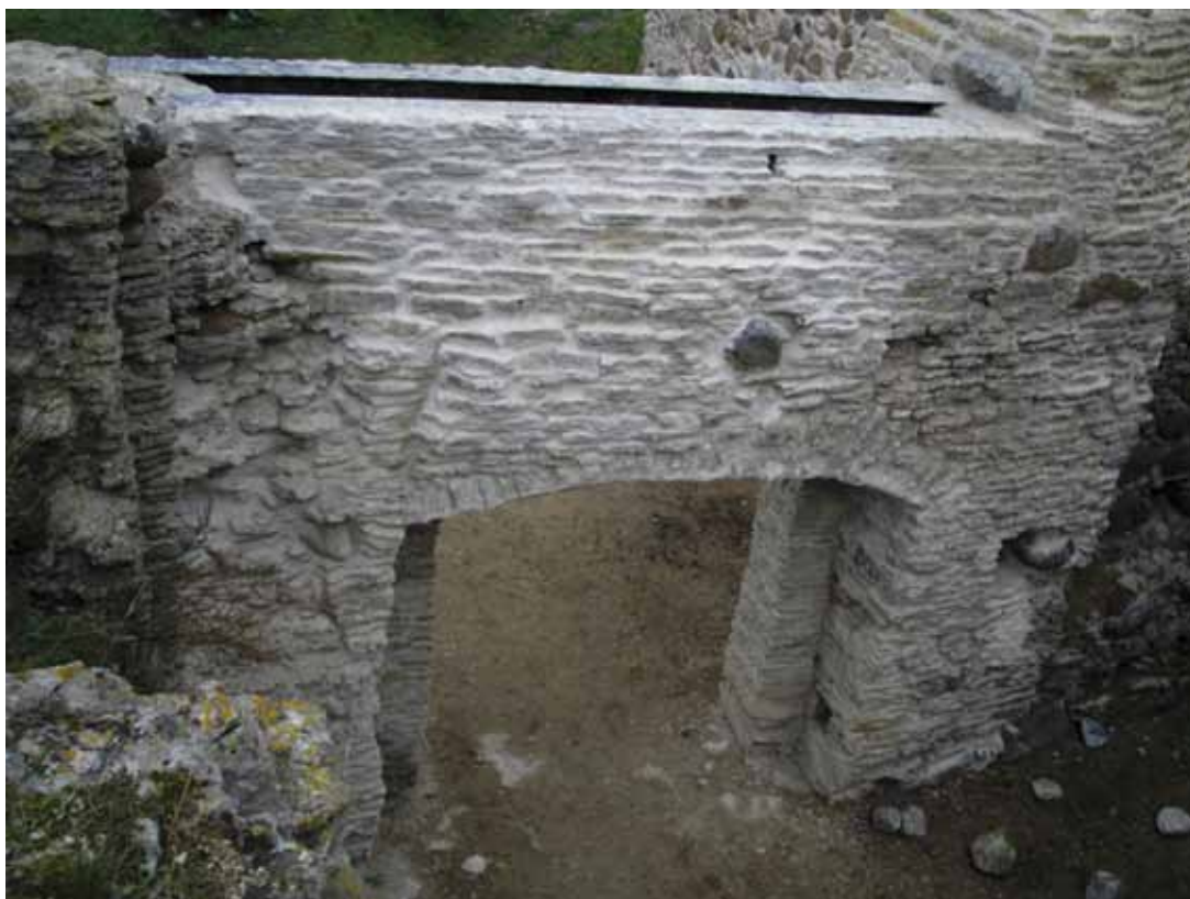
Foto 25. Väravasillust ülal hoidvad metalltalad (Foto: Uno Trumm, 2007).
