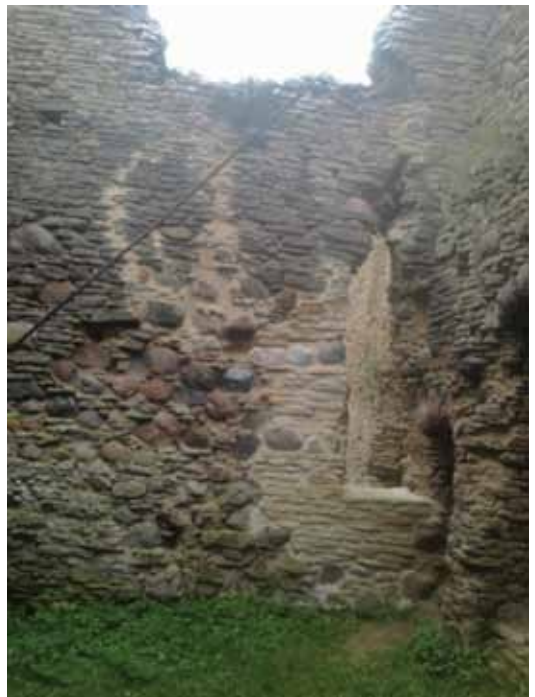
Foto 26, 27. Vaade läänetorni lõunaseinale. Juurdeladu müüri alaosas (Fotod: Uno Trumm, 2012).
