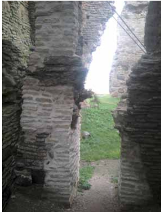
Foto 26, 27. Vaade läänetorni lõunaseinale. Juurdeladu müüri alaosas (Fotod: Uno Trumm, 2012).
