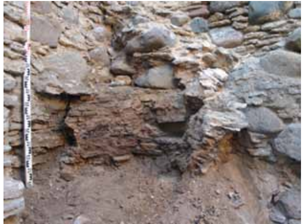
Foto 15, 16. Väravahoone idaküljel oleva šurfi põhjas oli näha kollase lubimördiga laotud teistsugune konstruktsioon, mida tõlgendati kui esialgse majalinnuse juurde kuuluvat palkpaliisaadi vundamenti. Parempoolsel fotol on kamin väravahoone loodenurgas (Fotod: Tõnno Jonuks, 2006).
