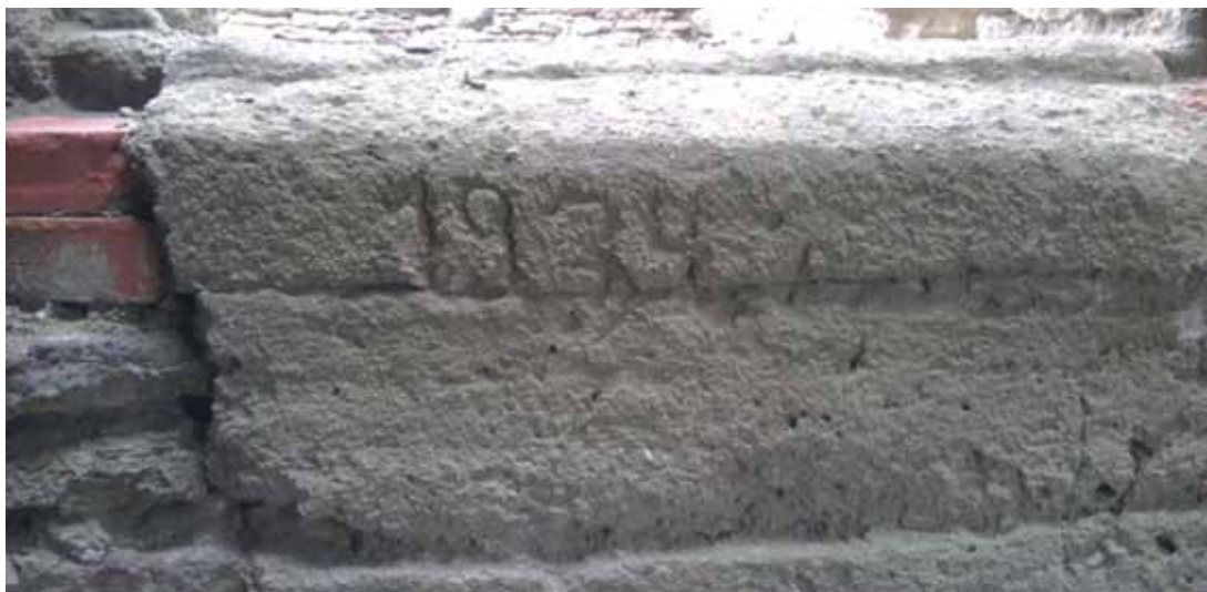
Foto 6. Lõunatorni ukse tsementmördiga valatud lävepaku siseküljel on betooni kraabitud aastaarv 1934 (Foto: Uno Trumm, 2012).
