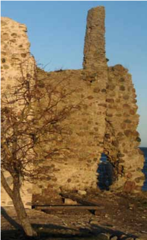
Foto 31, 32. Linnuse kaguosa müür enne ja pärast konserveerimist (Fotod: Uno Trumm, 2007, 2012).
