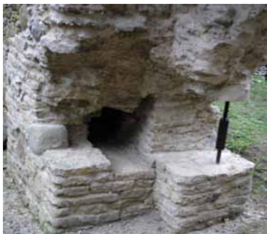
Foto 20, 21. Vaade konserveeritud väravapõskedele. Mõlemal väravapõsel on näha avad riivpalgi jaoks (Fotod: Uno Trumm, 2007).
