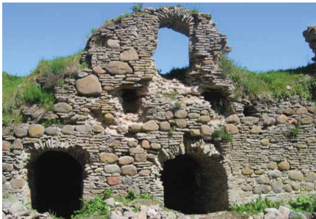
Foto 33. „Keldrite“ fassaadid enne konserveerimist (Foto: Uno Trumm, 2004).
