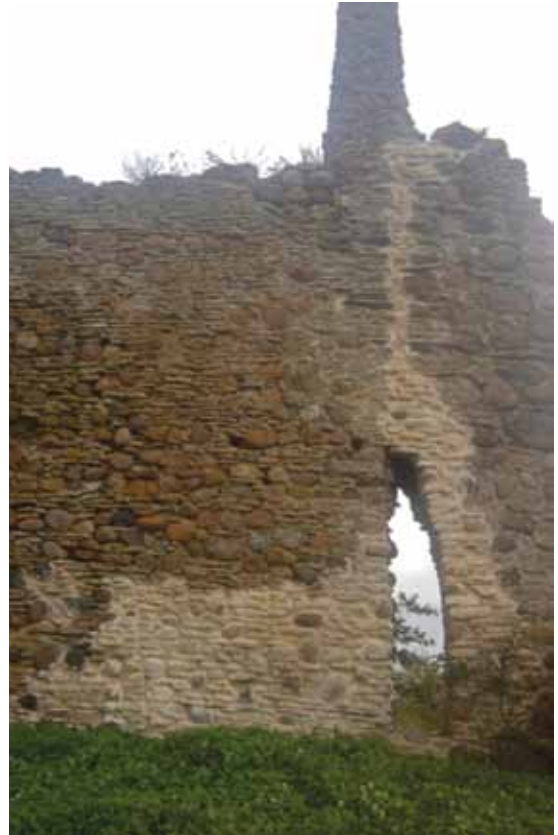
Foto 31, 32. Linnuse kaguosa müür enne ja pärast konserveerimist (Fotod: Uno Trumm, 2007, 2012).
