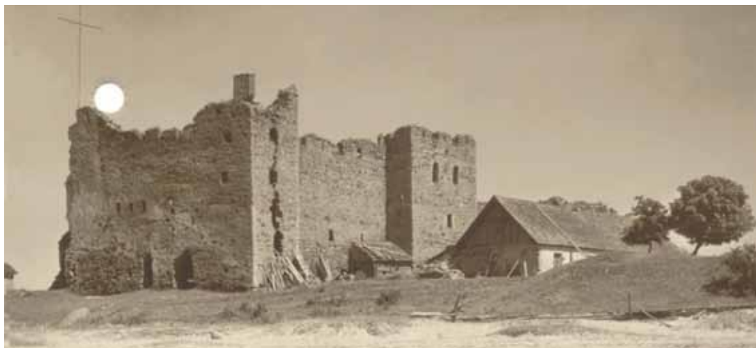
Foto 2. Linnus enne konserveerimist, esiplaanil lõhega läänetorn (RMF 100:365).
