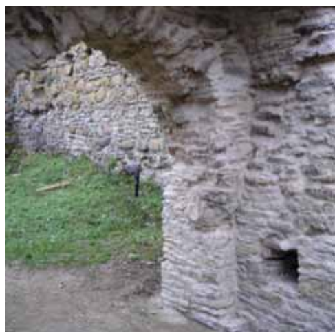
Foto 20, 21. Vaade konserveeritud väravapõskedele. Mõlemal väravapõsel on näha avad riivpalgi jaoks (Fotod: Uno Trumm, 2007).
