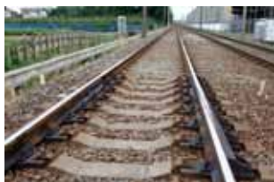
ロングレール化工を行った線路
