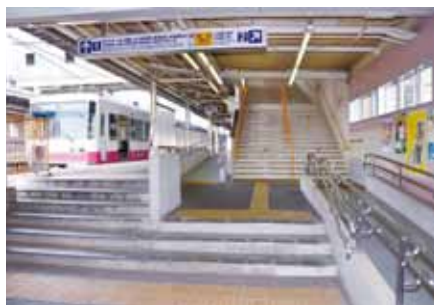
松戸新田駅下りホームスロープ
