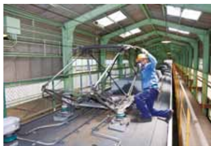
パンタグラフの点検（月検査）
