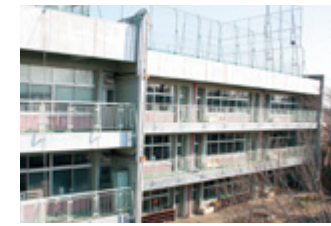
本館教室棟(東側教室部分)
