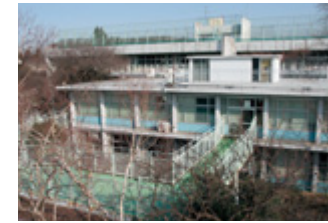
理科館(手前)と本館教室棟(奥)
