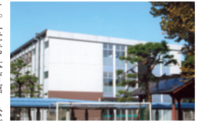
トンネル山校舎
