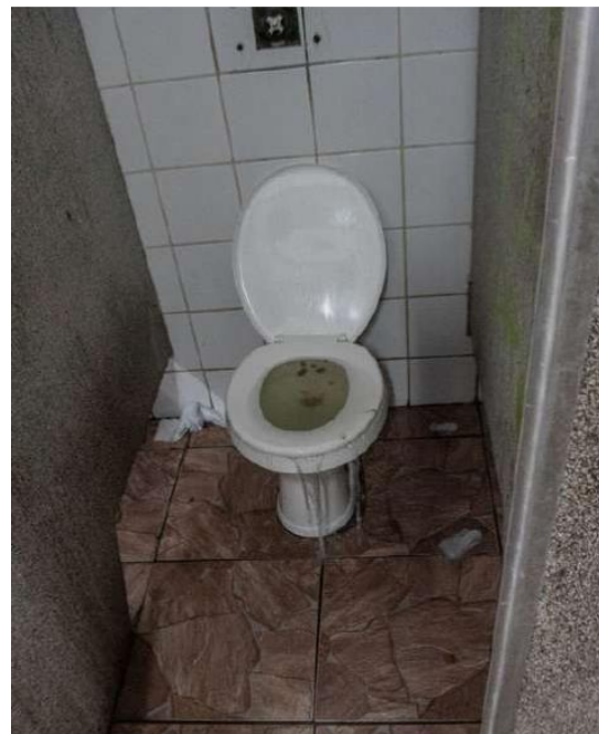
Vaso entupido com fezes transbordando no chão no CAE Zaki Narchi I.
