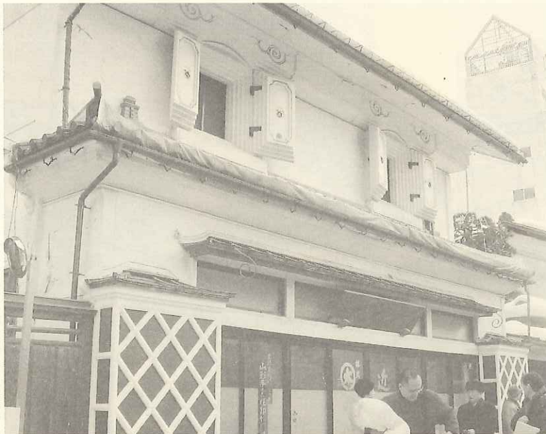
十日町に面して建つ丸太中村の全景
