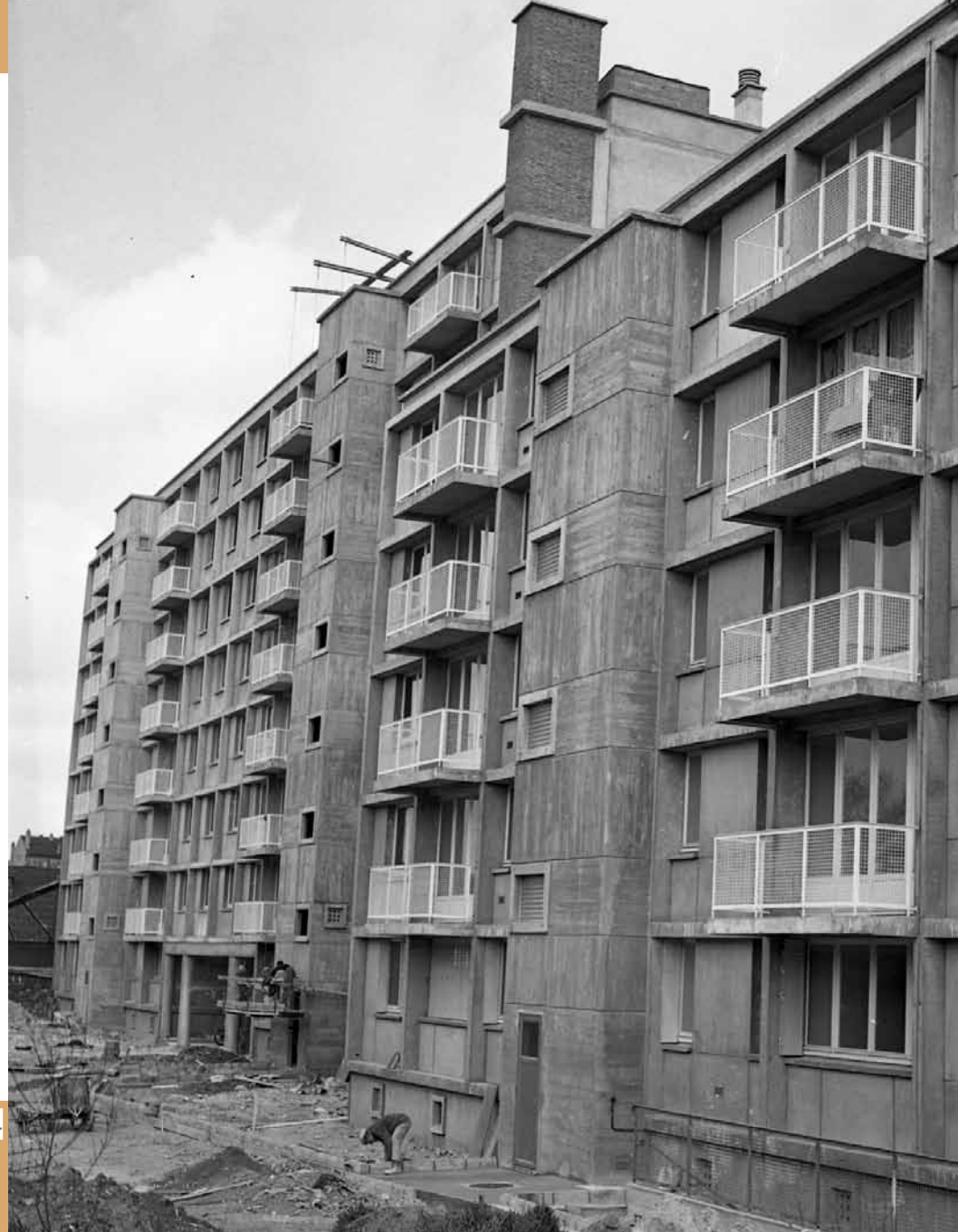
Construction de HLM rue Amilcar-Cipriani, 1960.
