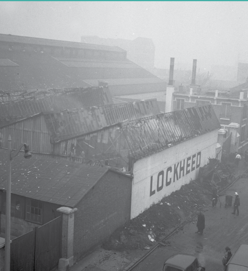
Incendie de l'entreprise Lockheed, rue Jules-Verne, 12 janvier 1953.
