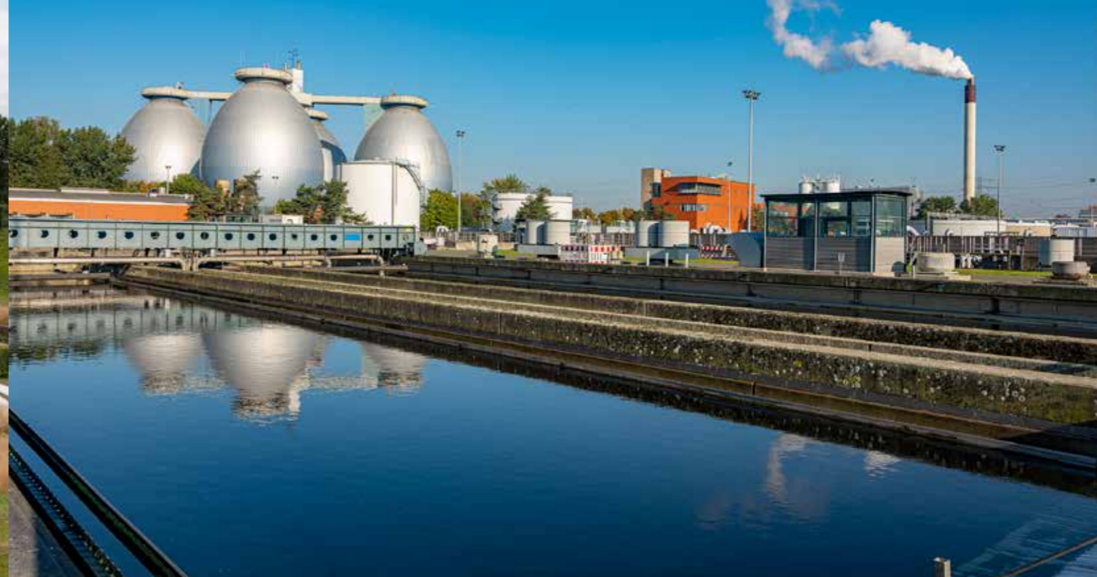
Die Kläranlage Bottrop. Foto: Klaus Baumers
