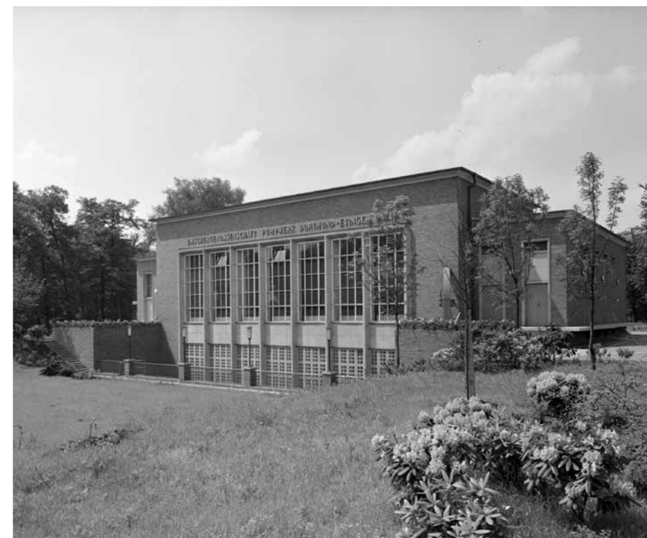
Das Pumpwerk Evinger Bach. Foto: EGLV
