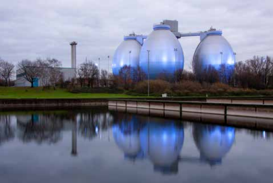
Das Klärwerk Emschermün- dung. Foto: Klaus Baumers
