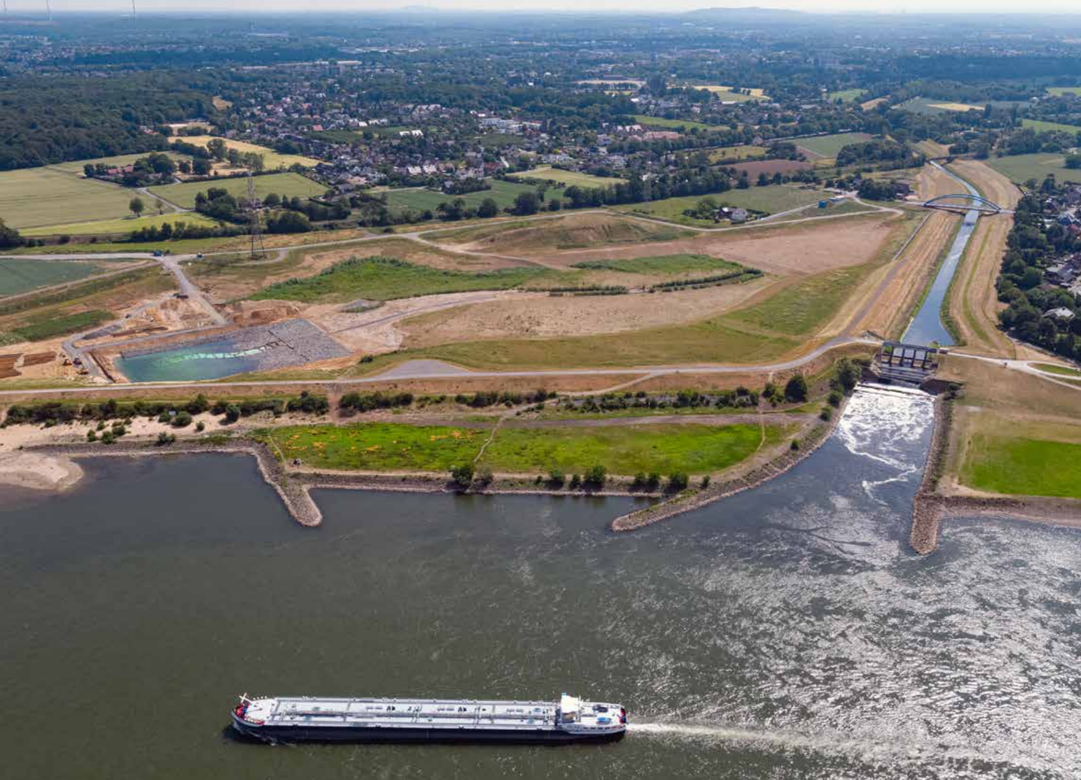
Das Absturzbauwerk am Stapp. Foto: Jörg Saborowski
