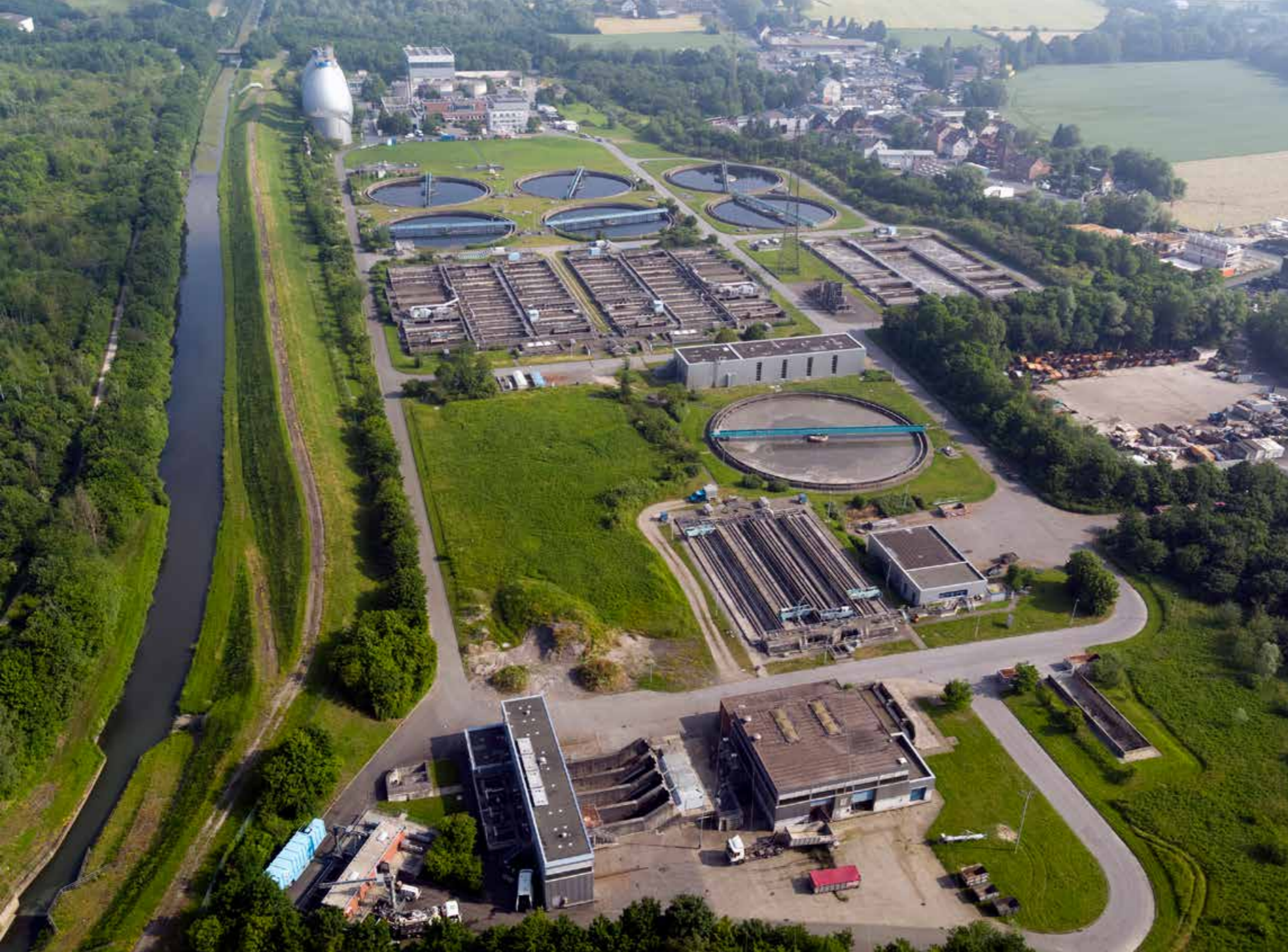
Die Kläranlage Dortmund-Deusen. Foto: Jörg Saborowski
