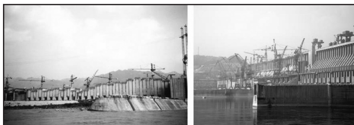
FIGURA 4. Imágenes de la construcción de la presa de las Tres Gargantas.
