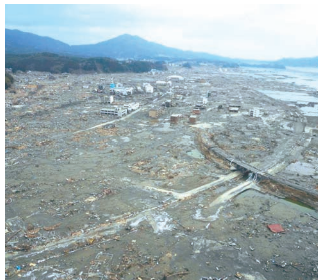
津波に飲み込まれた街 (岩手県陸前高田市)
