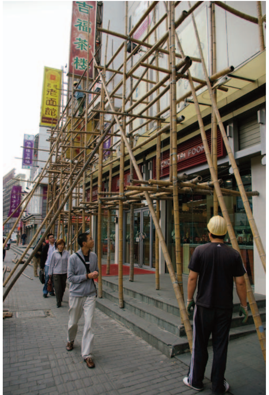
Ein seltener Anblick in Chinas Metropolen: Längst haben standardisierte Stahlgerüste die leichten Bambuskonstruktionen abgelöst. Bild: nova-Institut
