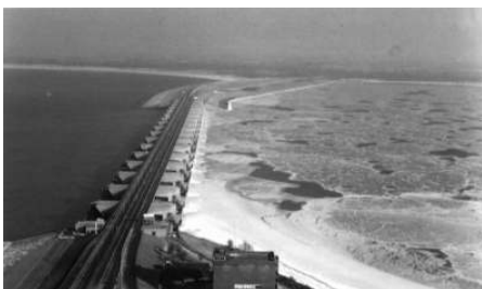
De Haringvlietsluizen in de winter. De openingen moesten breed zijn — en daarom de nabla-ligger heel sterk — met het oog op eventuele ijsgang, maar die heeft zich in de praktijk nooit voorgedaan.
