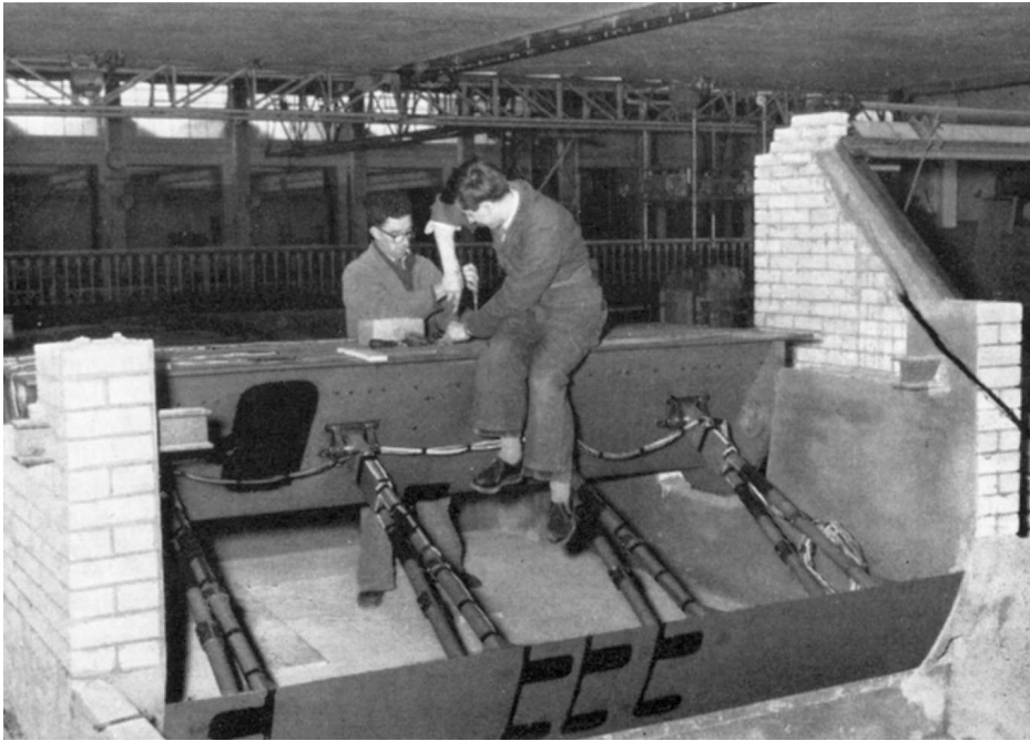
Schaalmodel van de Haringvlietsluizen in het Waterloopkundig Laboratorium in De Voorst. De ingenieur zit op het model van de nabla-ligger.
