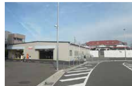
堺市内連続立体交差事業(浜寺公園仮駅)
