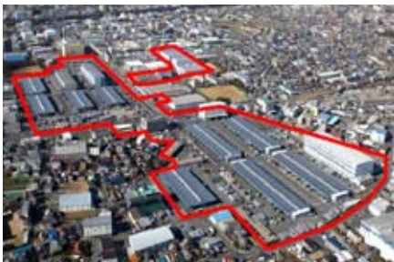
東大阪流通センター（総敷地面積 約218,000㎡）
