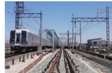
南海本線堺市内連続立体交差事業(石津川南岸)
