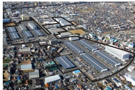
東大阪流通センター (総敷地面積 約213,000㎡)
