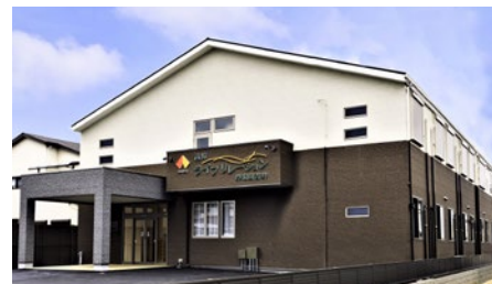
南海ライフリレーション岸和田吉井
