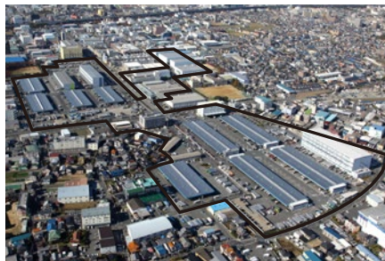
東大阪流通センター (総敷地面積 約227,000m 2 )
