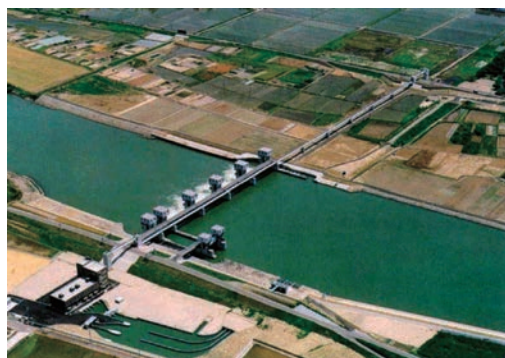
頭首工：河川から農業用水を安定的に取水する施設
