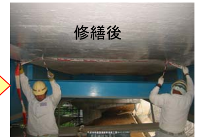
〔修繕例〕床版を補修し長寿命化を図ります
