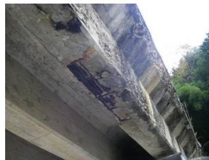
桁の損傷
