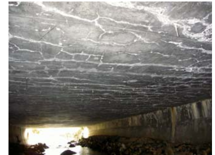
〔修繕例〕床版を補修し長寿命化を図ります
