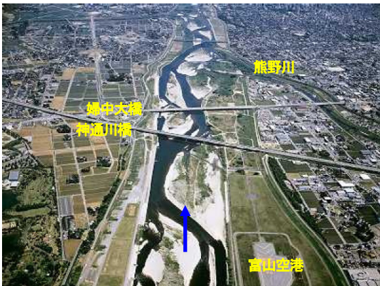
写真⑦ 神通川 13.0k 富山空港から下流を望む
