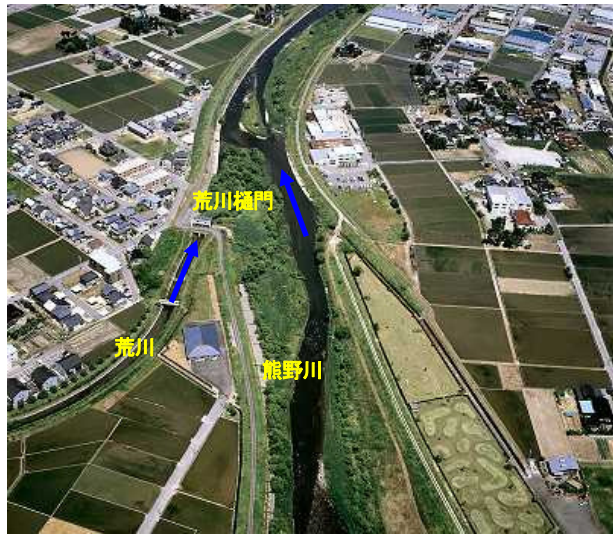
写真⑧ 荒川樋門付近
