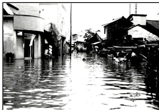
富山市浸水状況
