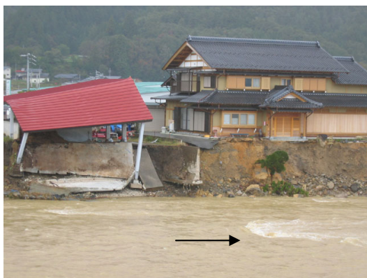
上流部被災状況 (高山市上切町)
