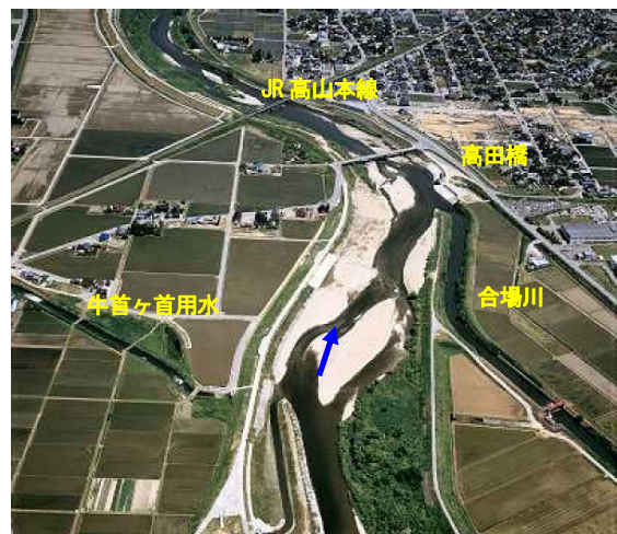
写真⑬ 井田川 8. 0k 高田橋上流から下流を望む
