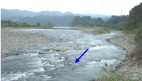
神通川 22. 3k 大沢野大橋から上流を望む
