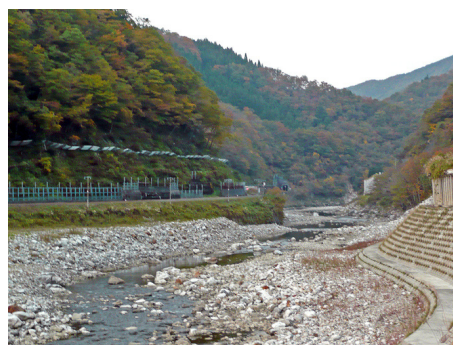
②水流のない箇所（打保ダム下流）
