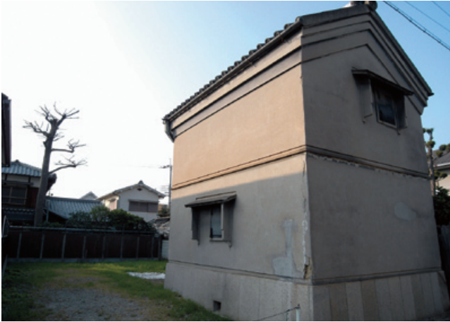
写真7 蔵が残された宅地（池田室町）
