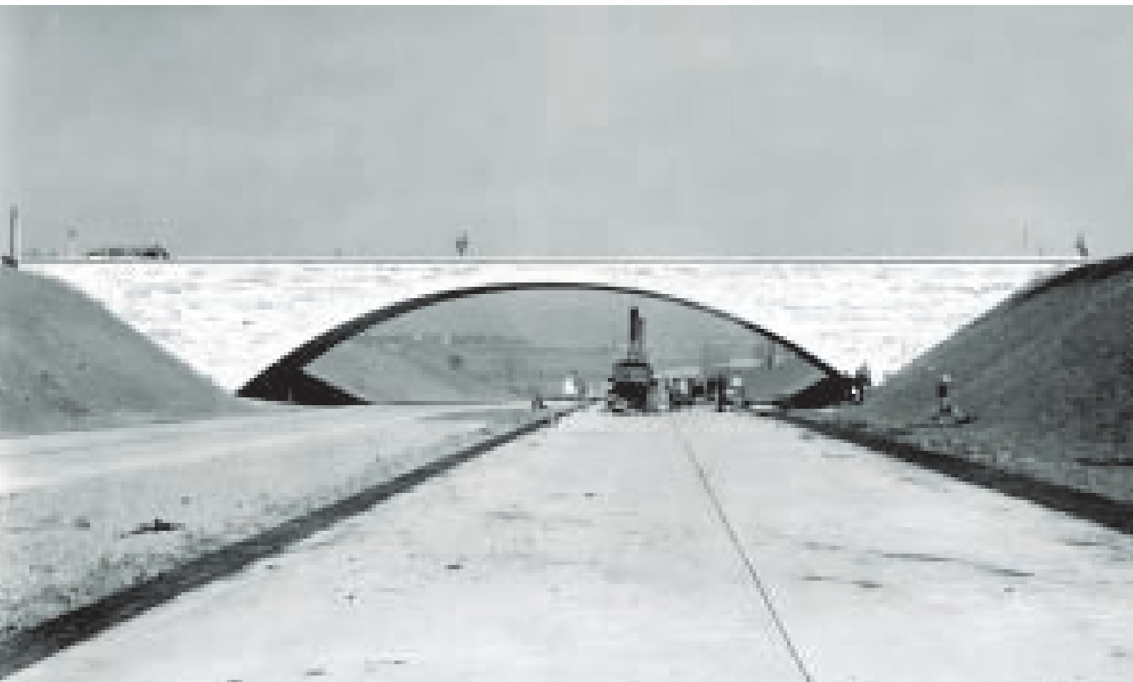
Überführung des Ortsverbindungswegs Eglosheim-Asperg über die Autobahn Heilbronn-Stuttgart, 1940.
