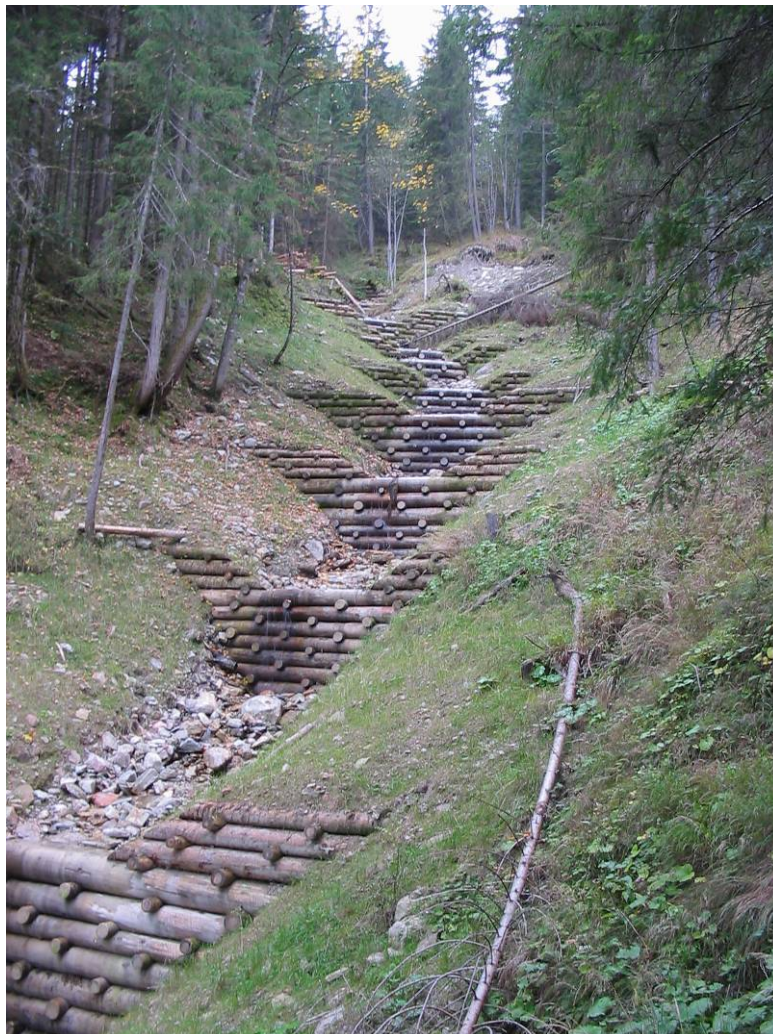
Abb. 16: Massive Verbauung am Herndllichgraben durch Abstürze kurz vor dem Talgrund
