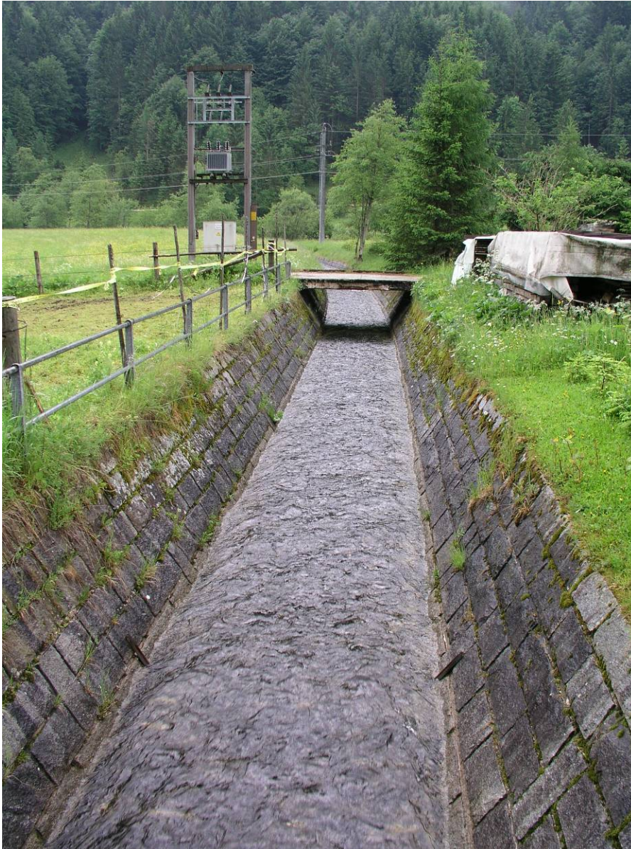
Abb. 17: Zu Gerinne ausgebauter Seitenbach des Gosaubaches im Talraum
