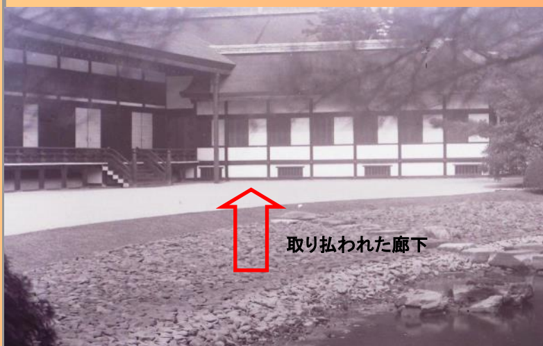
御学問所付近の写真(京都事務所保有のガラス乾板より)
