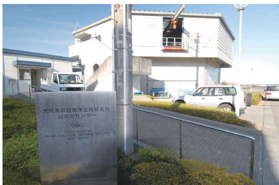
図1. 研究棟と第一水槽
