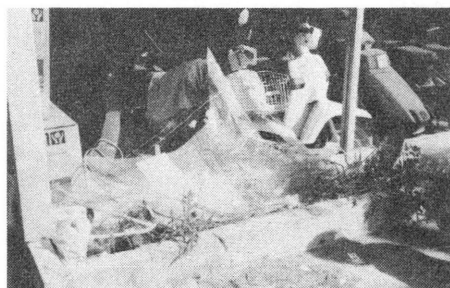
写真3 サッシ窓のわれ
