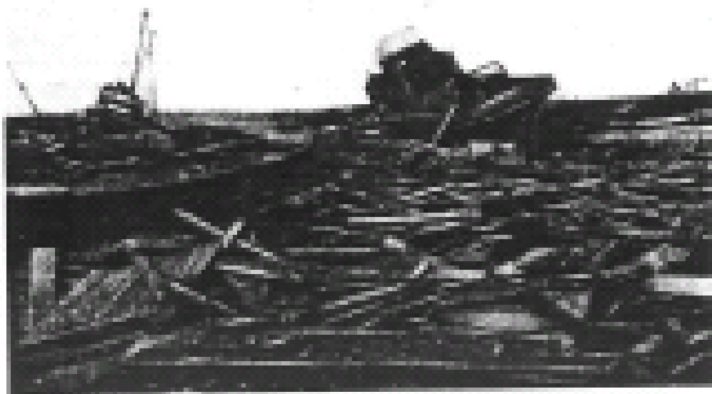
Фот. 22. Мусора и обломки домов, разбросанные на берегу после цунами в районе Козыревска
