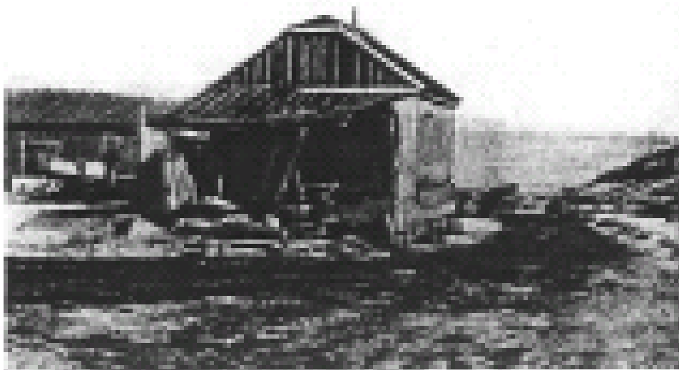
写真 9. 波、破壊された家、港の港に運ばれた家
