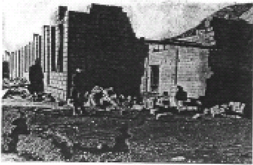
Фиг. 3. Сложившиеся трещины в пильных группах в разрушенной подстанционной котельной при металлургической фабрике в бухте Равной Авачинского залива
