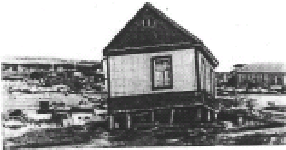
写真 8. 波、破壊された家、港の港に運ばれた家
