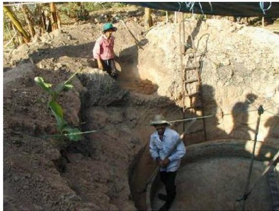
Gambar. 6.5.1. Reaktor fermentasi dalam pembangunan.
