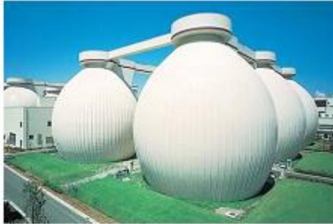
Gambar 8.2.2. Contoh digester anaerobik lumpur limbah skala besar.
