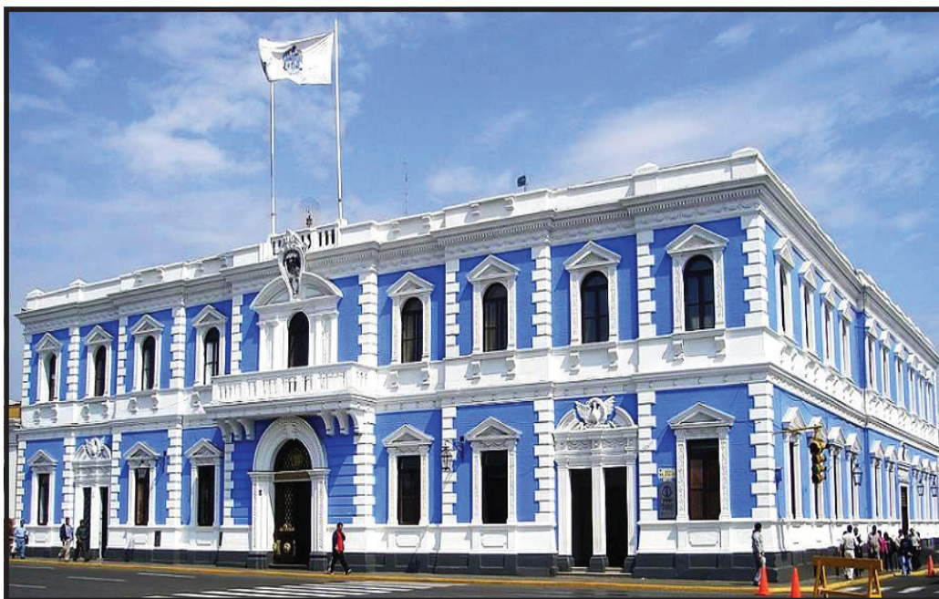
Frontis de la Municipalidad Provincial de Trujillo
