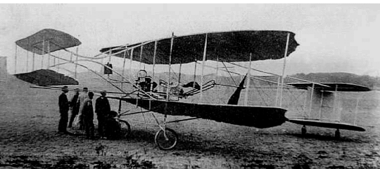
Le biplan Sanchez-Besa (1911) à mâture métallique fut le premier à monter le V12 Renault de 90 ch. (Archives mun. de Boulogne-Billancourt).
