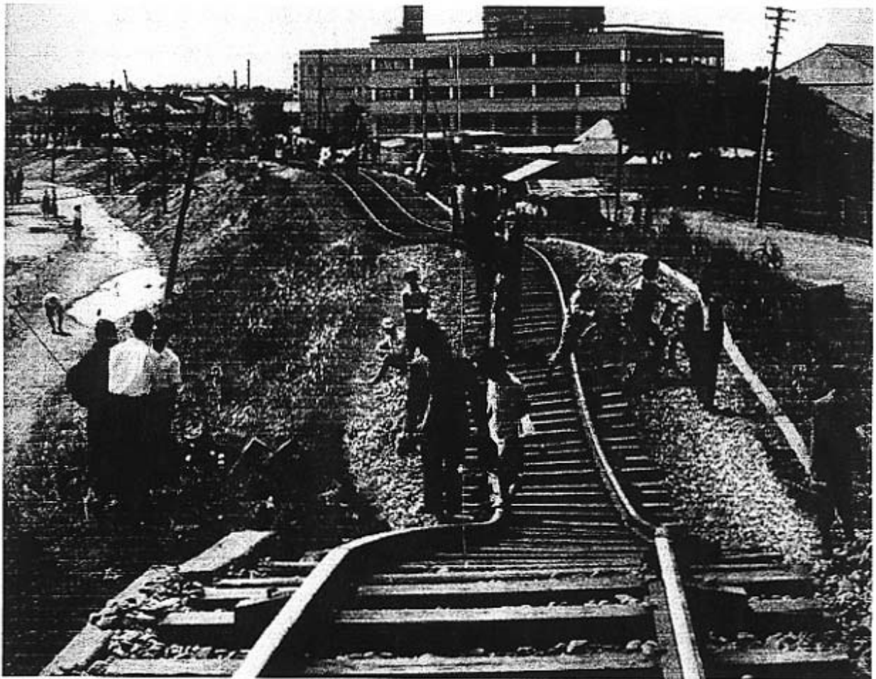
図3 1964年新潟地震 直後の国鉄越後線白山駅(新潟駅の西隣)付近の様子[新潟日報社(1964)による]. 一般には地滑りによる側方移動と説明されているが, 図2のような地震時の地盤の波動がそのまま線路に残されたものと解すべきだろう.
