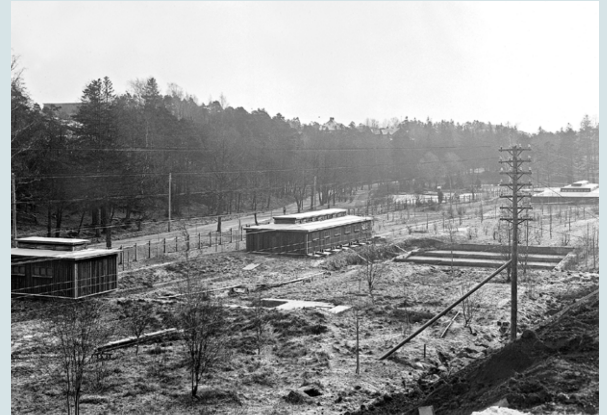
Helsingin ensimmäinen jätevedenpuhdistamo kuvattuna vuonna 1930 Alppipuiston laaksossa. Valokuva Foto Roos. HKM.
