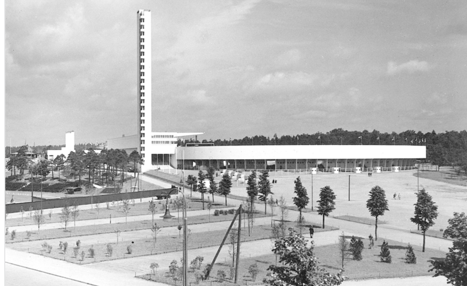
Kuva 83 | Vastavalmistuneet Olympiastadion ja Stadionipuistikko. 1938. Valokuva Foto Roos. SUM.
