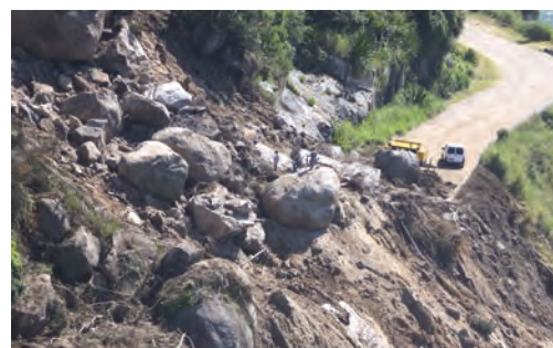
Photo 4.8: Estrada da Guanabara, linking Prainha to the Praia de Grumari.
