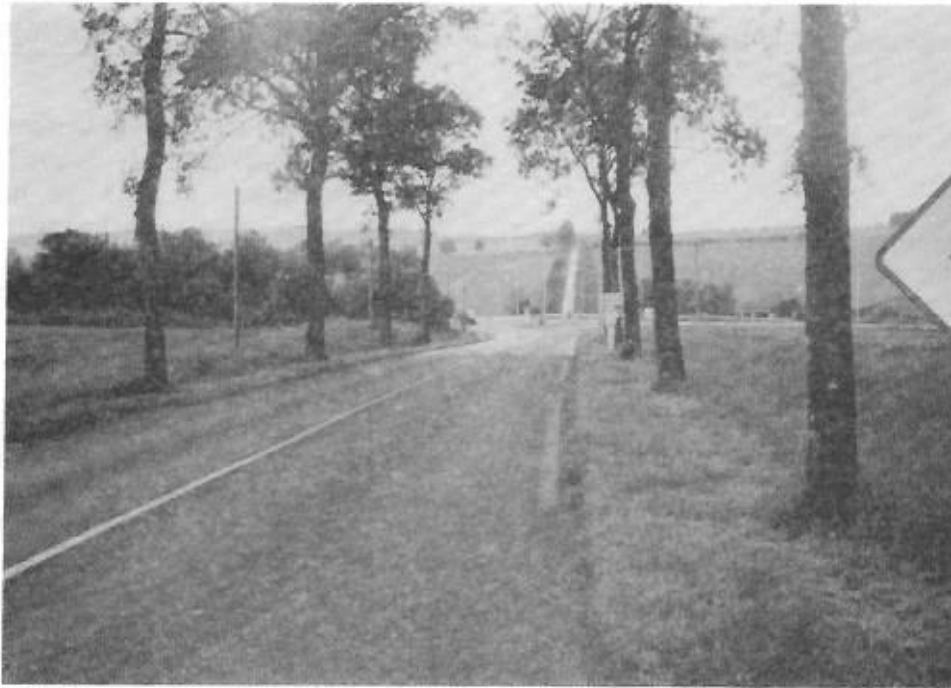
Le carrefour dit "des 4 vents" entre la voie Saint-Mihiel-Avant-Garde et l'ancienne voie romaine Toul-Scarpone (N 411)
