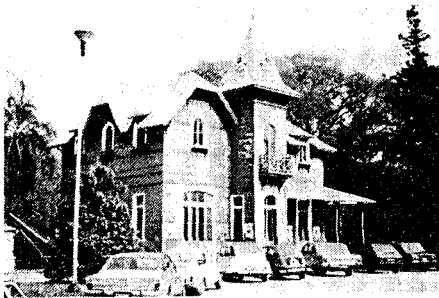
Fig. 5 Cette construction de type "chalet" comporte des éléments pittoresques et romantiques. Les quelques constructions de ce type qui ont été importées des Etats-Unis à la fin du XIXe siècle avaient un caractère provisoire. Il s'agit ici de l'un des rares exemplaires existant encore (Parc Saavedra). Bien que destiné (à l'époque) à la bourgeoisie platense , ce type de construction en bois a toujours été considéré comme pauvre et sans prestige.
