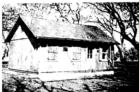
Fig. 6 Ce type de baraquement était destiné aux premiers habitants de La Plata (ouvriers). Il s'agit de constructions provisoires et préfabriquées importées des Etats-Unis entre 1882 et 1886. On les trouvait principalement au centre de la ville jusqu'à la fin du XIXe siècle. Ces baraquements n'étaient jamais construits sur la línea municipal mais plutôt dans le fond des parcelles. Il s'agit ici de l'unique exemplaire restant (Parc Saavedra).
