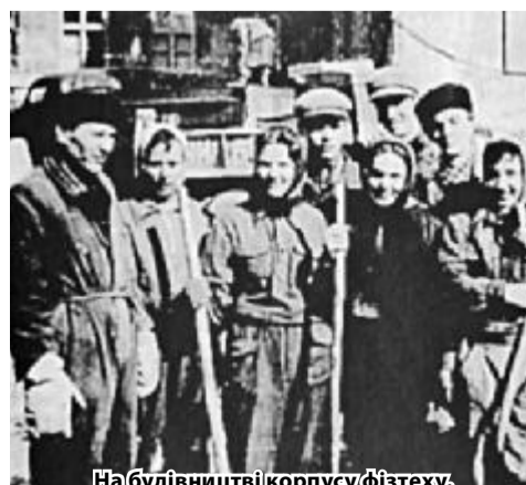
На будівництві корпусу фізтеху.
