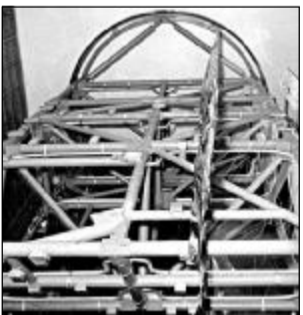
Термостабілізація просторової ферми за допомогою теплових труб.
