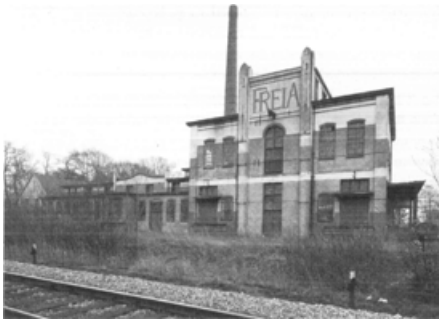
De zuivelfabriek Freia in Veenwouden werd in 1879 opgericht en was de eerste stoomzuivelfabriek in de provincie Friesland. In 1903 kreeg het bedrijf een nieuw onderkomen. Tachtig jaar later stond het pand er zó bij. Inmiddels is het gesloopt, maar de oude fabrieksinventaris is overgebracht naar het Openluchtmuseum in Arnhem.
