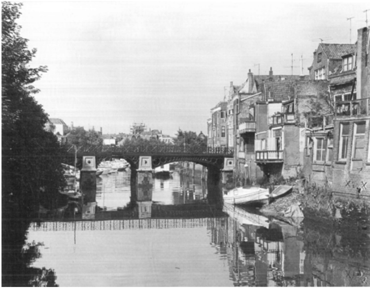
De Nieuwe Brug over de Wijnhaven in Dordrecht is een gaaf voorbeeld van de gietijzeren bruggen die in de jaren vijftig en zestig van de negentiende eeuw door diverse stadsarchitecten werden ontworpen.
