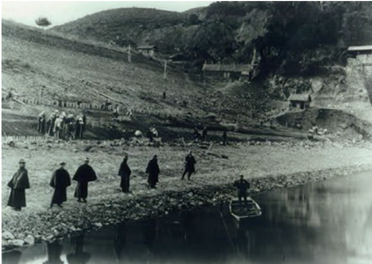
入鹿池百間堤 堤体築造の状況（明治16年） <出典：全国水土里ネット「水土里デジタルアーカイブス」>
