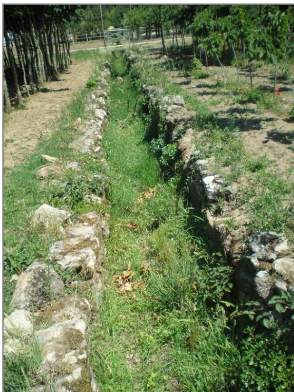
Figura 87 Leito da ribeira entre muros de pedra
