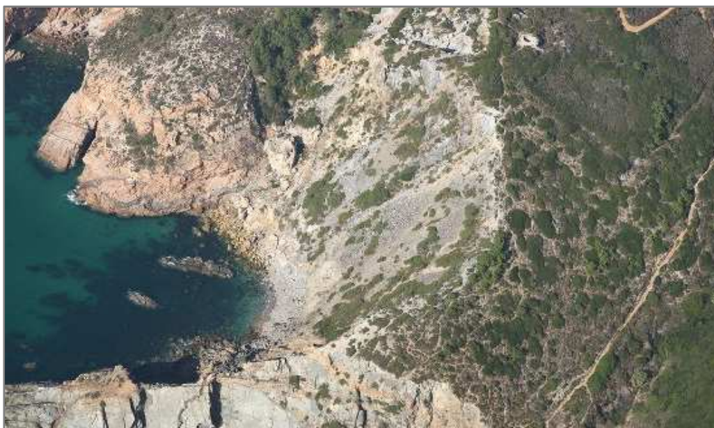
Figura 32 Instabilidade do tipo Escorregamento ou Deslizamento
