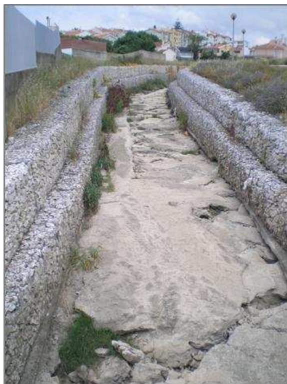
Figura 52 Muros de gabiões
