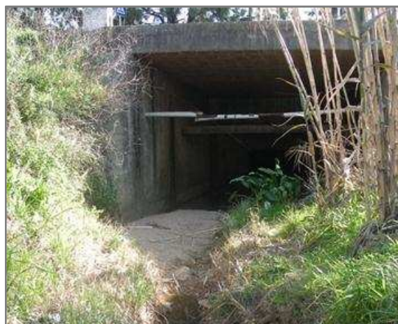
Figura 64 Secção canalizada subterraneamente
