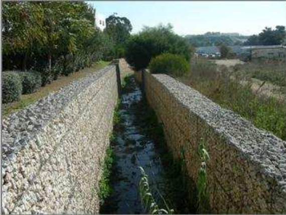
Figura 66 Secção com muros de gabiões
