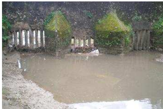
Figura 80 Estrangulamentos de secção junto à foz
