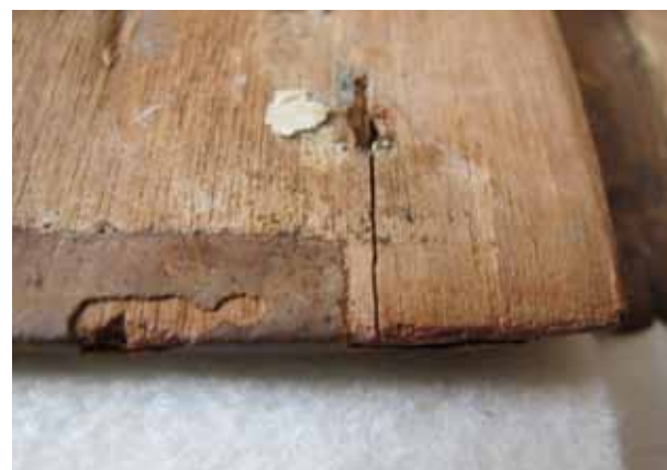
14 - Aspecto de uma fissura presente nas pastas em madeira
