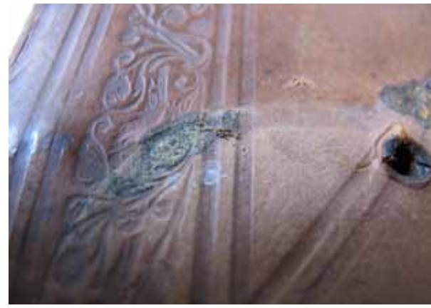
39 - Aspecto da pele após remoção das ferragens
