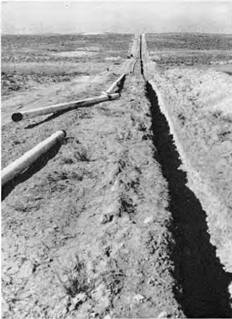
Bau einer Rohrleitung im Negew
