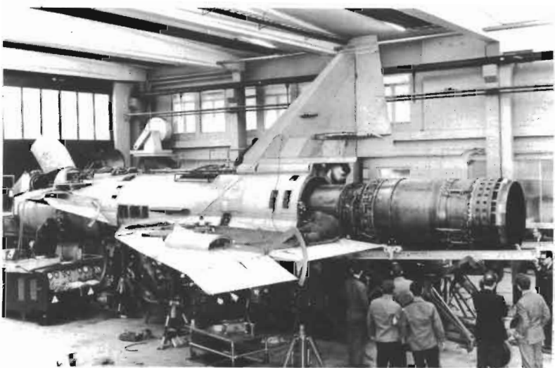
Den väldiga RM 8-motorn justeras in på sin plats i flygplanskrovet.
