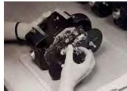
Montage de la platine et du mécanisme dans le bâti de la caméra H16, 1954. Archives cantonales vaudoises, fonds Paillard-Hermès-Precisa, PP680/3185.
