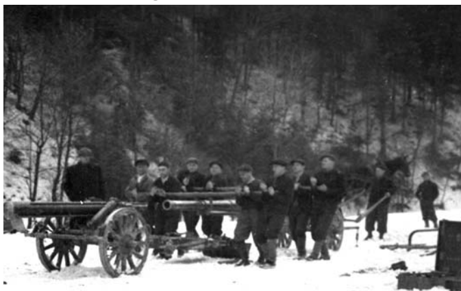
Comisia română de recepție a obuzierului “Skoda” cal. 100 mm, model 1939 executând trecerea țevii de pe trăsura de transport pe afet.
