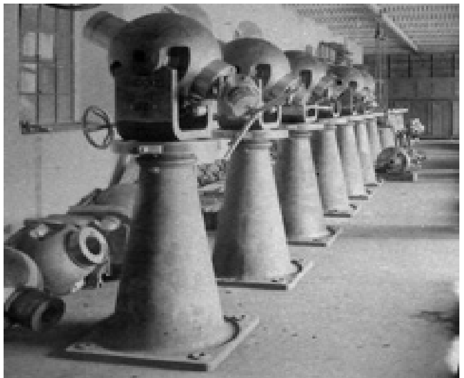
Mortiere "Krupp" cal. 120 mm în procesul de fabricație. Construcția era identică cu cea a modelului uzinei "Gruson". În perioada analizată firma "Krupp" a preluat și firma "Gruson".
