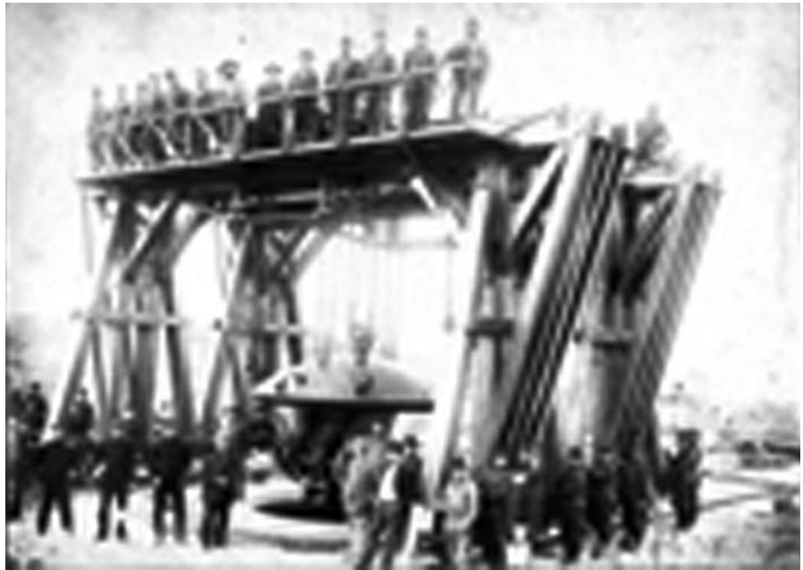
Montarea unei turele "Gruson" pentru obuzierul "Krupp", cal. 210 mm.
