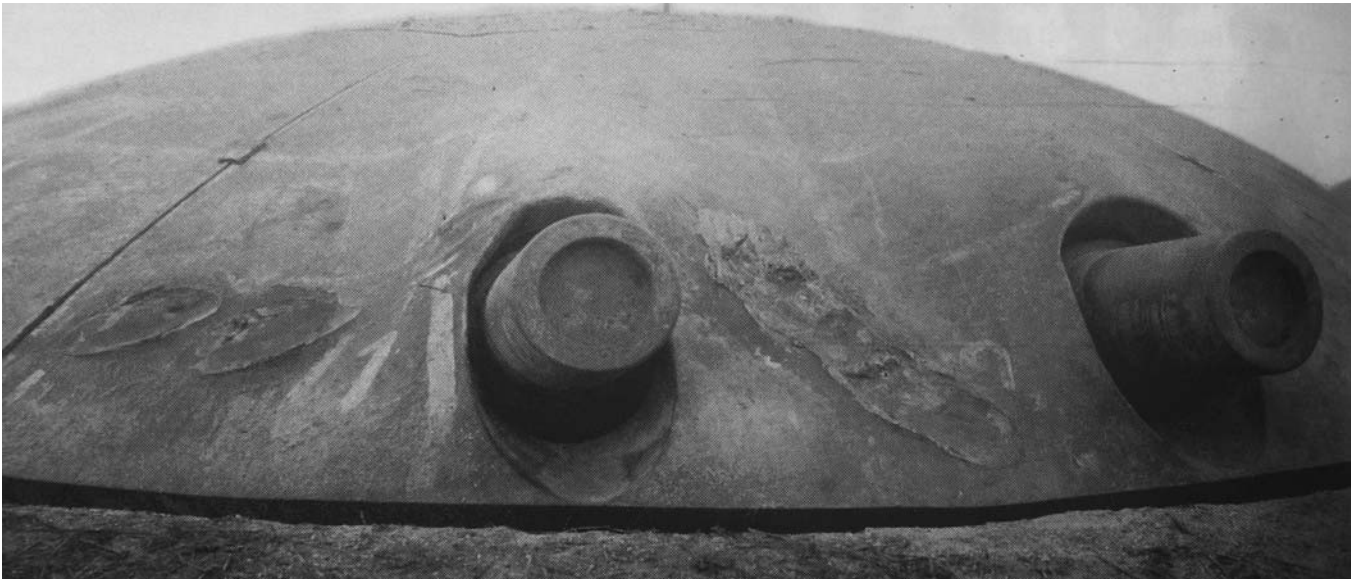
Cupolă "Montlucon" fabricată de firma "Chatillon&Commentry", model 1891, pentru două tunuri "Krupp", cal. 150 mm. Reproducere după Cornel și Ioan I. Scafeș, "Cetatea București", Ed. ALPHA, MDN, 2008.
